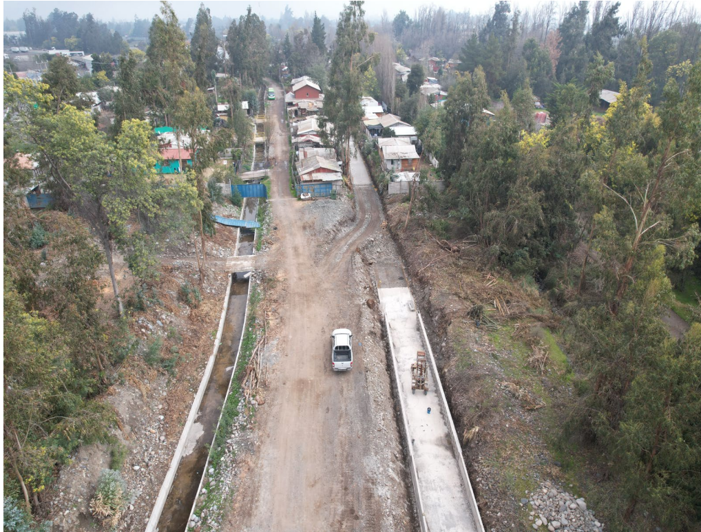
Revestimiento Canal Apaltas
