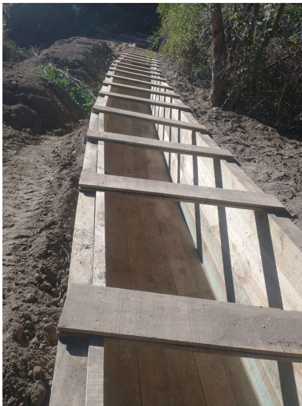
Construcción de Canal en Tablones Impregnados Canal Peumal Sector Francisco Lecaros
